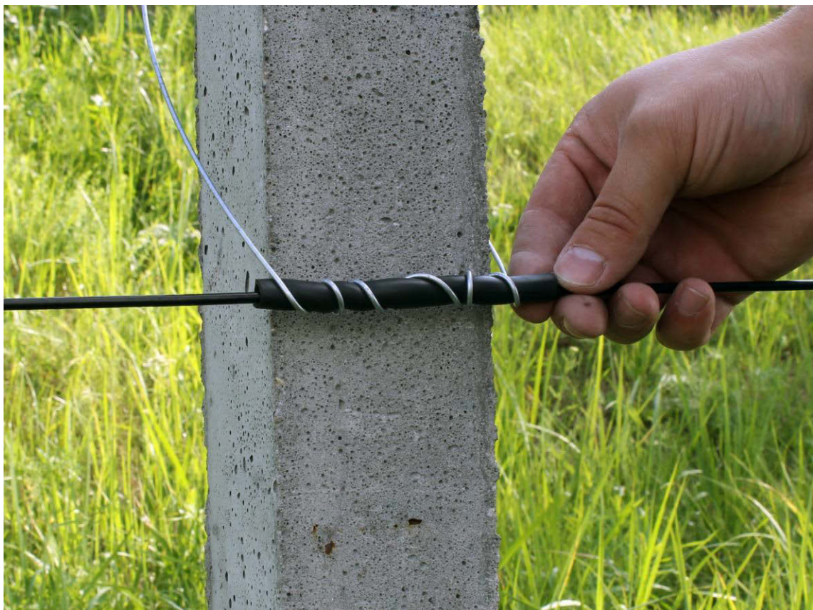
Обкрученная проволокой трубка
