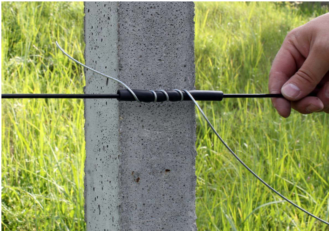
Обкручивание трубки проволокой
