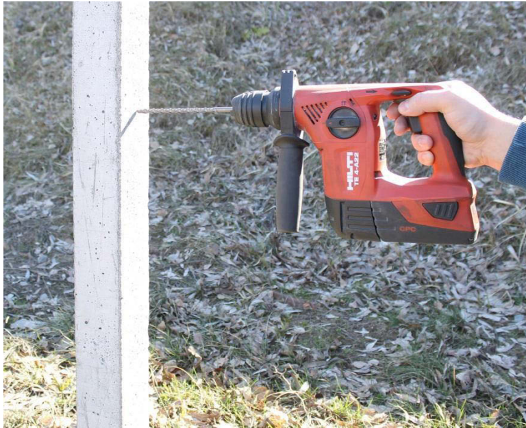
Сверление бетонных столбов
