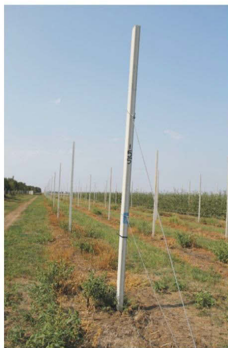
Железобетонные шпалерные столбы
