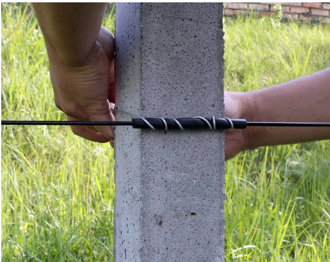
Закрепление проволоки на столбе
